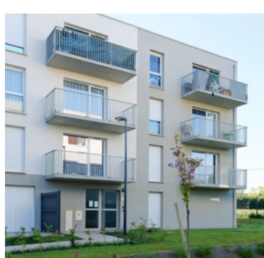
VERMELLES 47 COLLECTIFS Rue Florent Evrard VEFA auprès des Lotisseurs du Nord Architecte Agence Delassus, Dumoulin, Prévost Architecture
