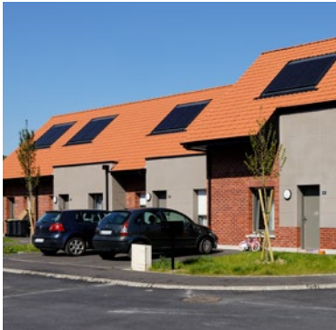
ROOST-WARENDIN 21 INDIVIDUELS (Tranche 1) Cité Bon Architecte cabinet A2bis
