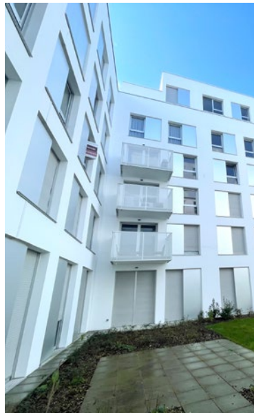
LILLE 16 COLLECTIFS Quartier Jean-Macé, rue Gosselet VEFA auprès de Sogeprom Architecte Saison Menu & Associés
