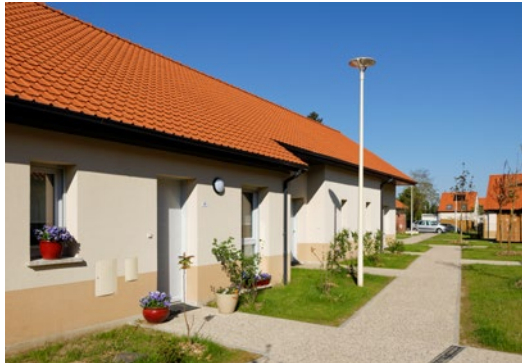
ROUVROY 30 LOGEMENTS (10 individuels et un béguinage de 20 logements de plain-pied) Rue Henri Barbusse, cité Nouméa Architecte Scénario-ARA
